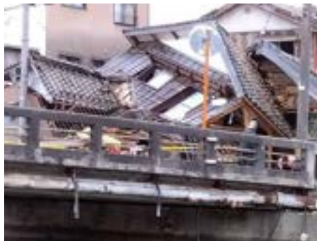
石川県穴水町 民家の被害 （1月5日）
