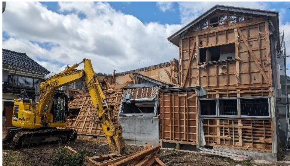
解体工事の様子
